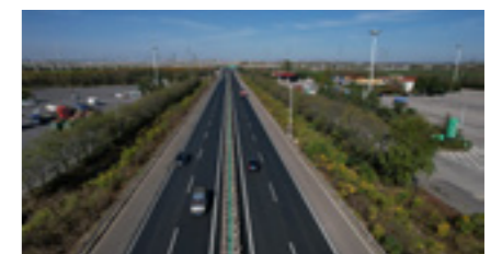
养护后的沙河特大桥桥面
