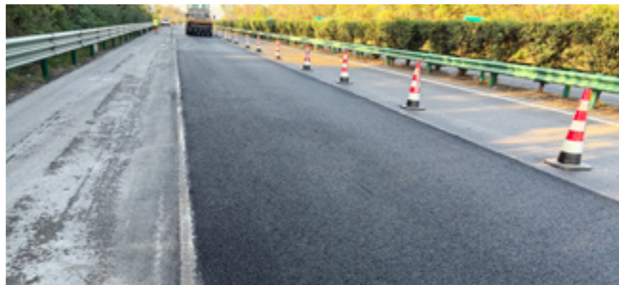
运用钢渣沥青混凝土技术养护高速公路路面
